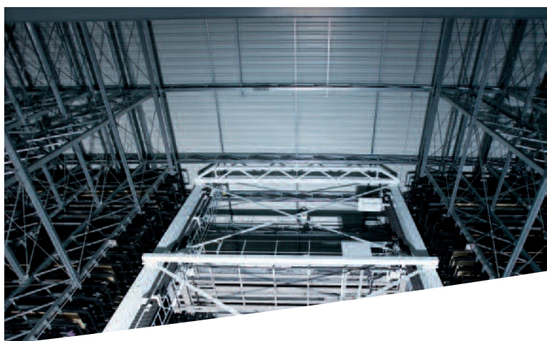
Dachanschluss am Wabenregalblock.
