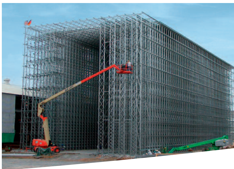
Fertigstellung eines Wabenlagerstahlbaus mit Dach- und Wandanschluss.
