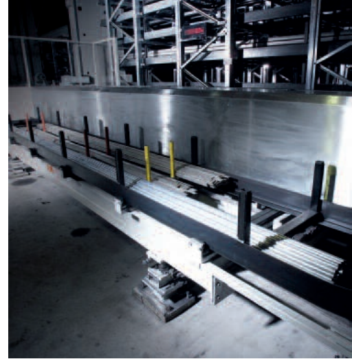
Kassette an Umlaufstation mit Schutzhaube.
