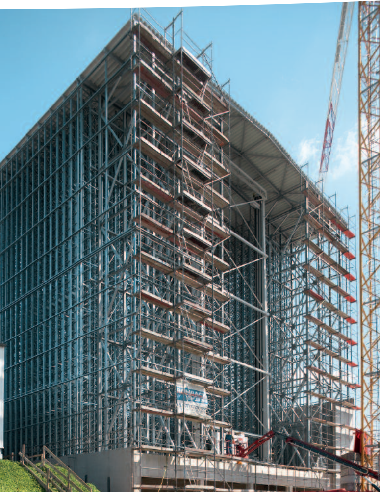
UNICOMPACT gebäudeträger während der Montage.
