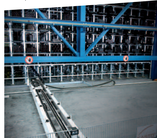
Pufferstation an der Lagerlängsseite mit 14 Pufferplätzen.
