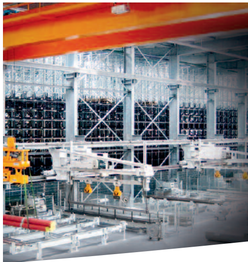
Materialbündelförderer mit Kommissioniergerät.
